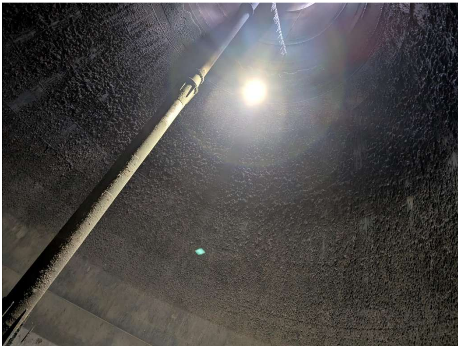
Blick aus dem oberen Mannloch zur Behälterspitze (ca. 23 Meter)
