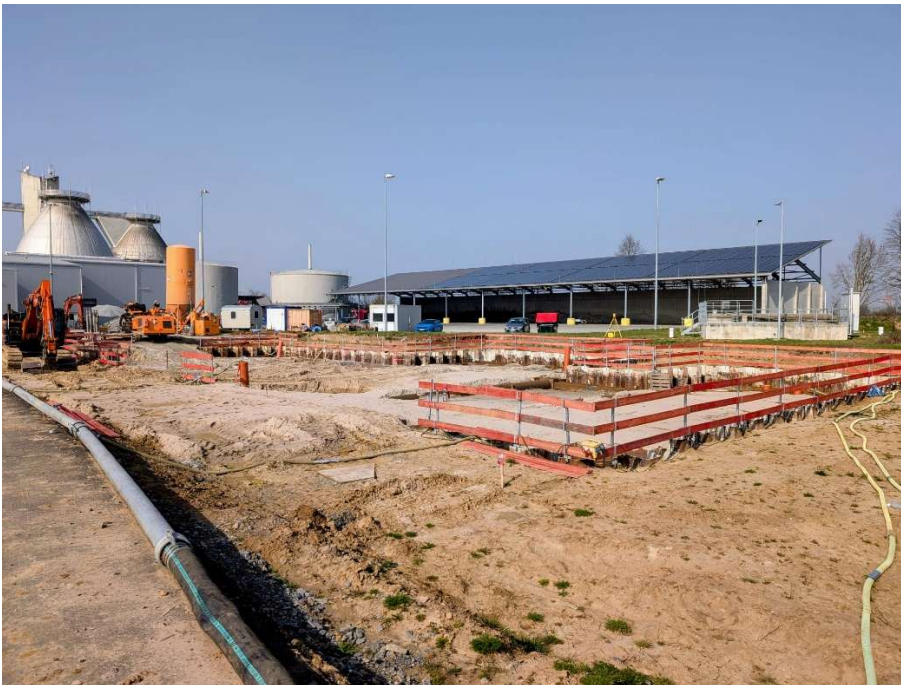
Baugrube mit Verbau von Aushub
